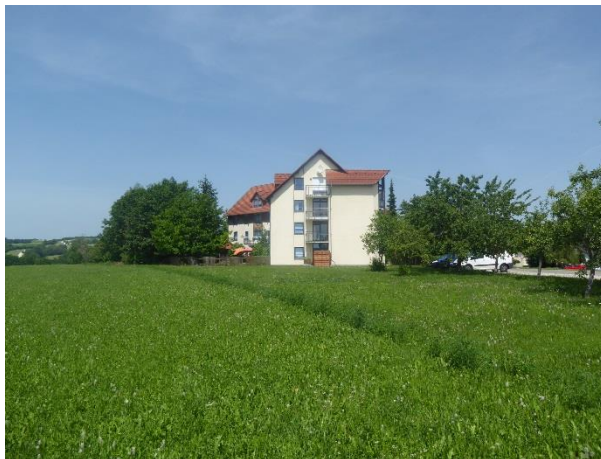
Blick auf das bestehende Pflegeheim vom südlichen Rand des Geltungsbereichs in Richtung Norden
