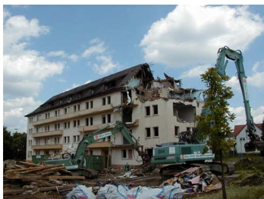
Abriss von Wohnraum in der Europastraße
