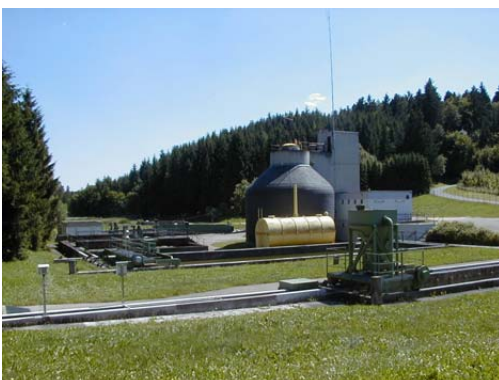
Bundeswehrkläranlage „Kohlthal“ Die Gemeinde ist mit Teilen angeschlossen.
