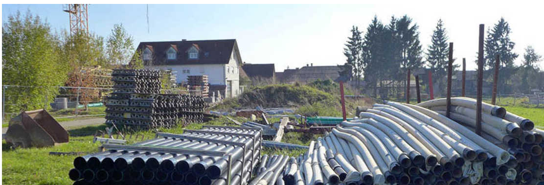
Foto 2: Blick aus nordwestlicher Richtung auf den Lagerplatz.
