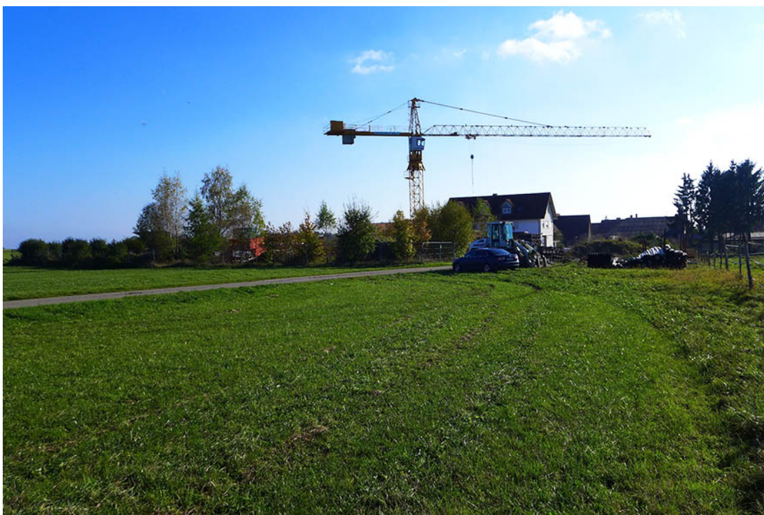
Foto 1: Blick von Norden auf das Plangebiet.
